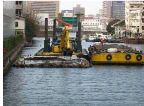
運河の汚泥浚渫の様子
