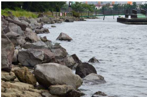
水辺に創出した近自然型の護岸 （大井ふ頭中央海浜公園）
