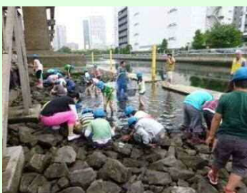
水生生物に配慮した護岸
