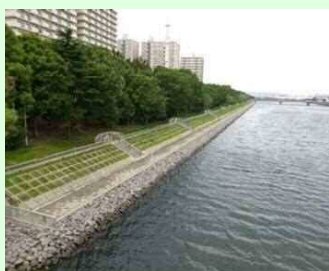
緑地・緩傾斜型防潮堤
