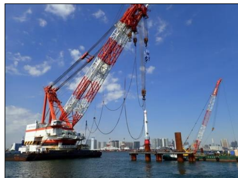
鋼管杭打設状況 H30.4 写真
