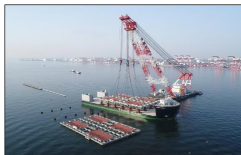
ジャケット据付状況 H30.4 写真
