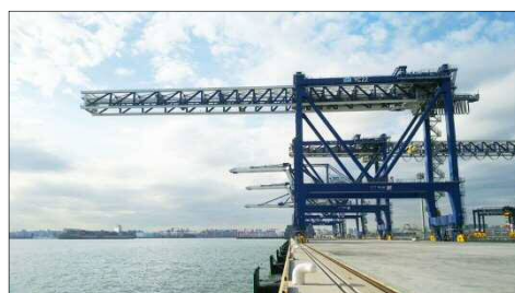
中央防波堤外側コンテナふ頭 整備状況
