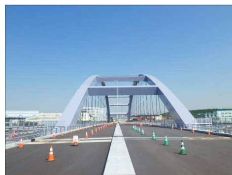
東水水路横断橋 整備状況
