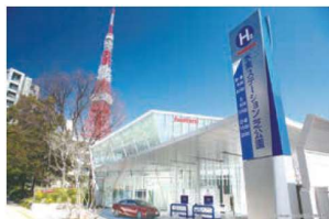
水素ステーション
