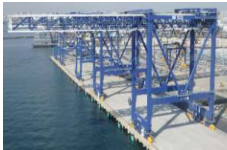
耐震強化岸壁・免震クレーン
