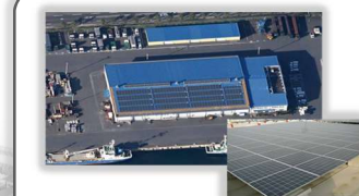
太陽光パネルの整備
