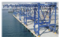
耐震強化岸壁・免震クレーン
