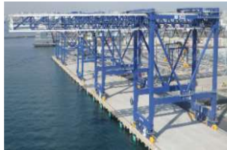
図 I -3-3 耐震強化岸壁・免震クレーン
