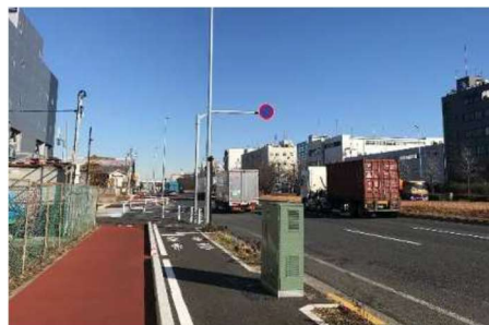
図 I -3-4 臨港道路の無電柱化
