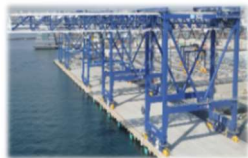
耐震強化岸壁・免震クレーン
