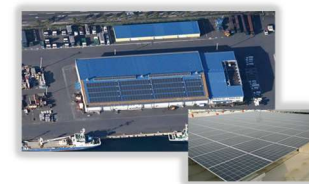
太陽光パネルの整備
