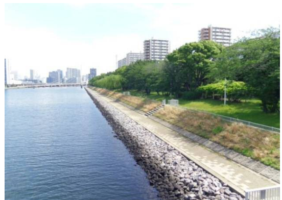
改修済み護岸 (既定計画区域)
