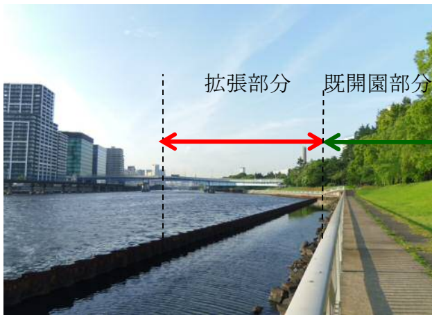
改修前護岸 (今回計画区域)
