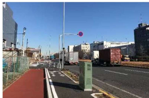
臨港道路の無電柱化
