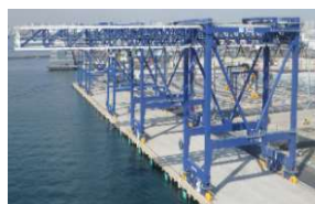
耐震強化岸壁・免震クレーン
