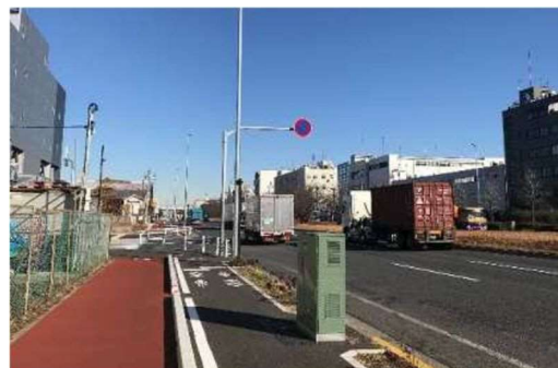
臨港道路の無電柱化
