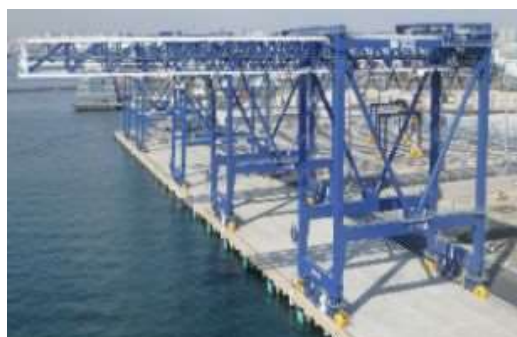
耐震強化岸壁・免震クレーン
