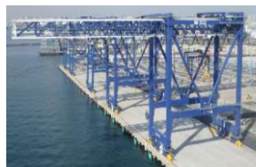
耐震強化岸壁・免震クレーン
