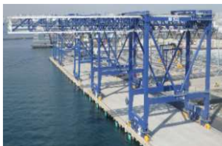
耐震強化岸壁・免震クレーン
