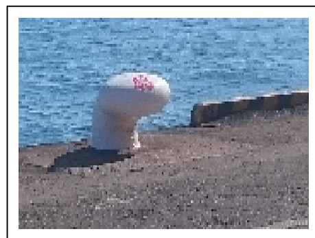
係船柱の維持補修
