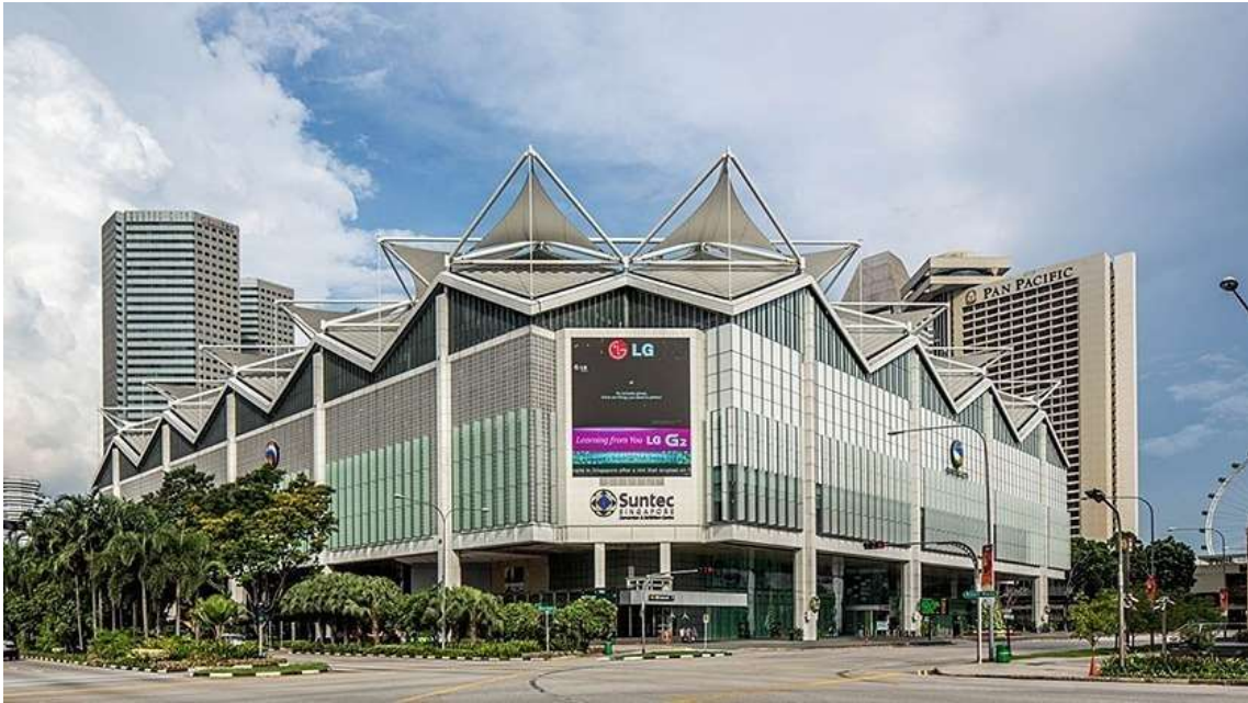
図表 3-48 サンテック・シンガポールの外観
