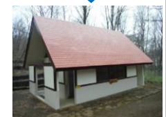
利用者から改善要望の多かったトイレの改修 (都立東大和公園)
