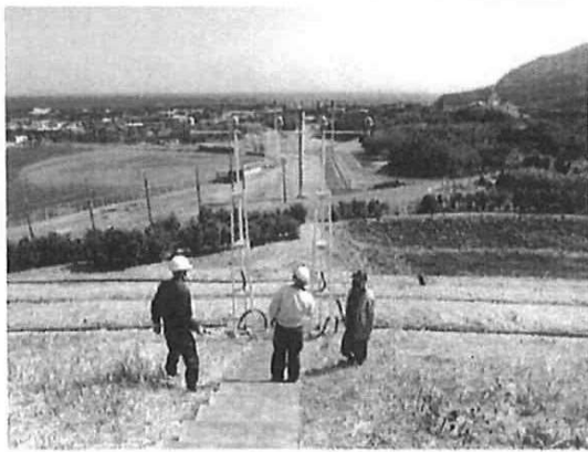
簡易式進入灯のうち、SALS 6 の状態を確認。
