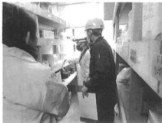
電球等保管用の棚には落下防止の返しがあり、地震等への対応がされている。
