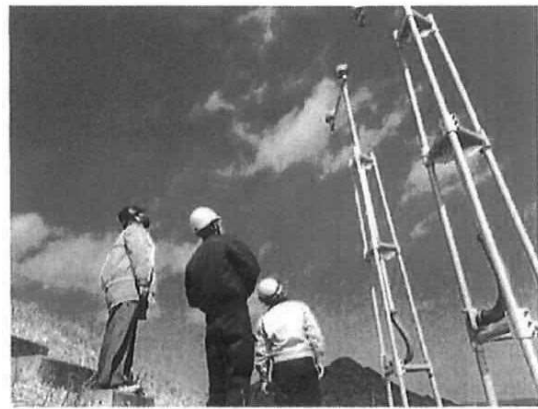
支柱には錆、その他劣化は見られず。
