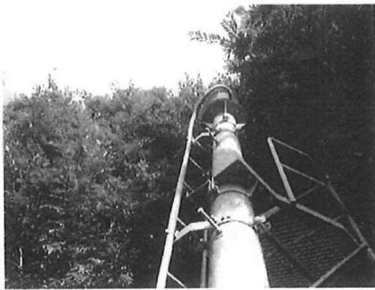
塔柱・灯器とも外観は目立った錆等は見られなかった。
