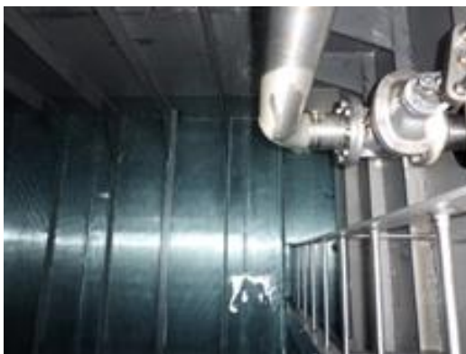
【清潔な運搬給水船給水タンクの内部】
