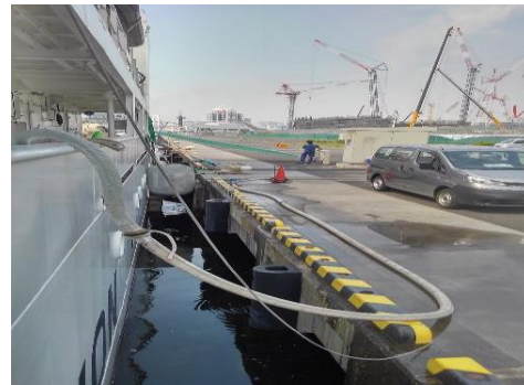
【客船への給水作業】
