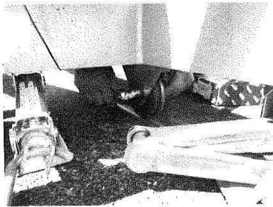
安全対策としてジャッキ2個使用
