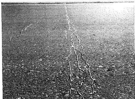
作業翌日、硬化後の状態
