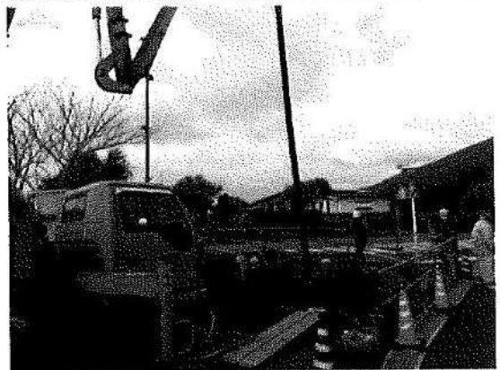
同じく、更新工事の様子。
