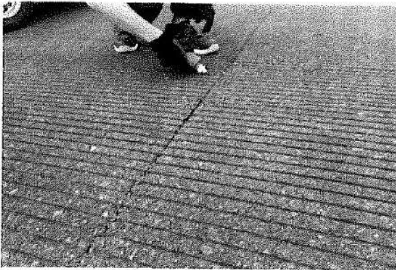
補修材をひび割れ部に注入する。
