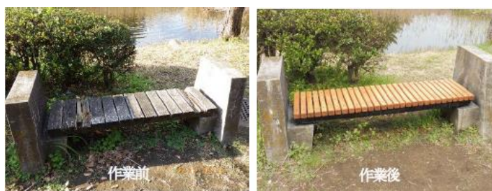
< みなとが丘ふ頭公園 ベンチ補修 >
