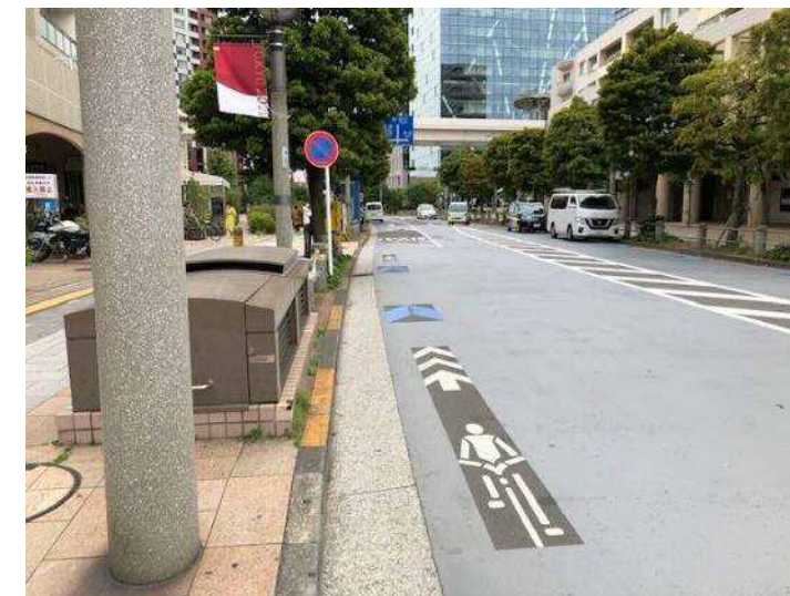
東京都港区 台場1号線（港湾局管理道路）
