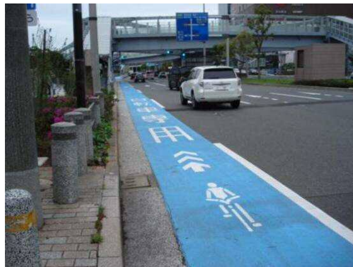
東京都港区 台場15号線（港湾局管理道路）
