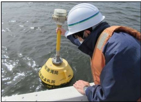
灯浮標の点検
