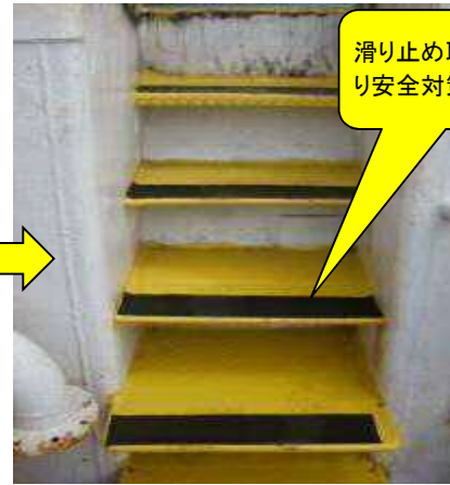
架設通路の転倒防止
