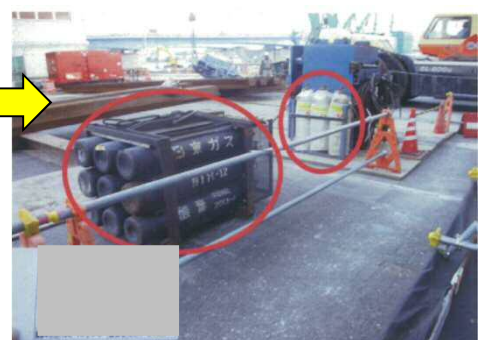
アセチレン及びガス集合溶接装置の管理
