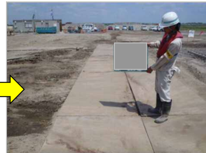
敷鉄板の段差・ずれによるクレーン等の転倒を防止
