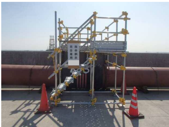
作業船の乗降場所における転落防止設備の設置
