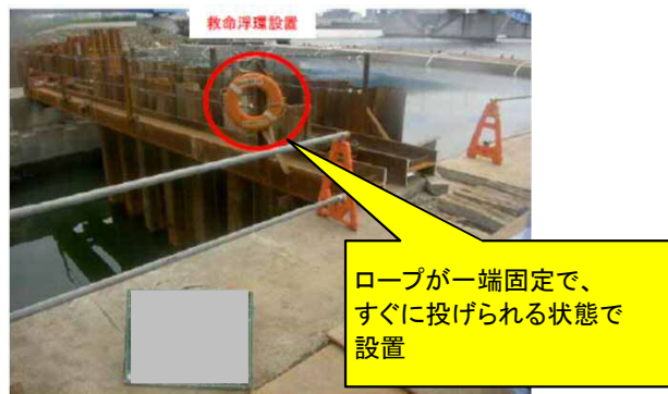
救命浮環設置
