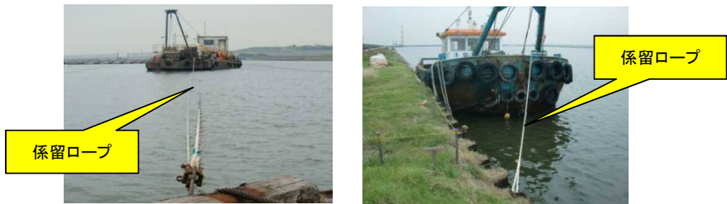
作業船係船時の安全確認
