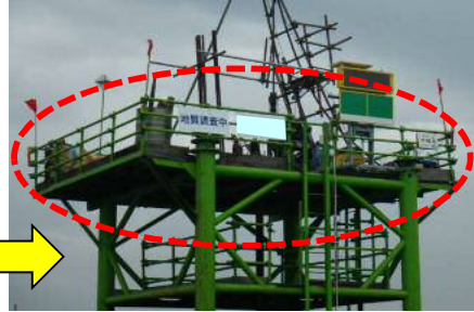
ボーリング檣の手摺改善
