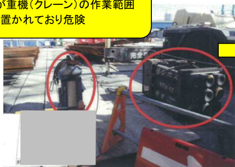
アセチレン及びガス集合溶接装置の管理
