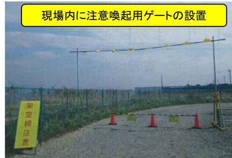
注意喚起用ゲート設置
