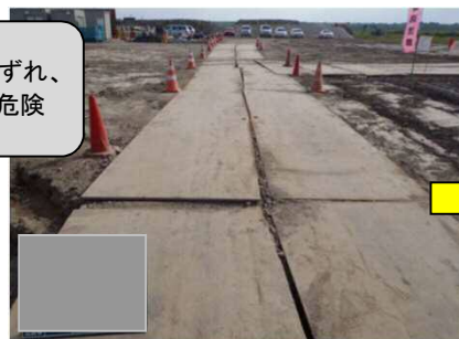
敷鉄板の段差・ずれによるクレーン等の転倒を防止
