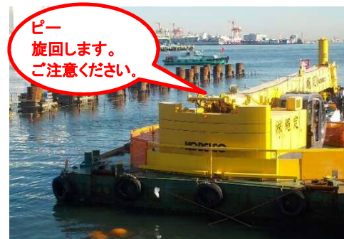
回転灯及び警報装置の設置
