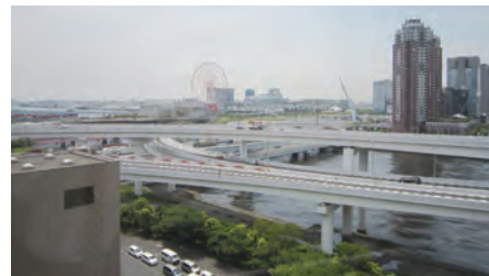
首都高速湾岸線付近
