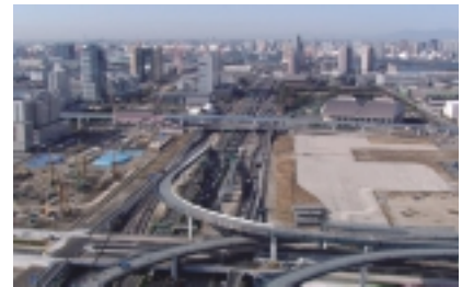
首都高速湾岸線付近
