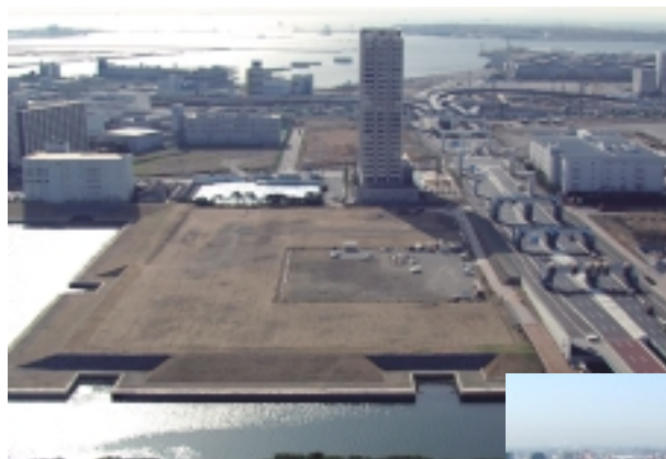
放射第34号線支線1の東側付近
