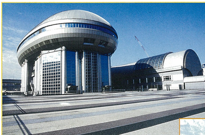
クリーンセンター 有明処理場
