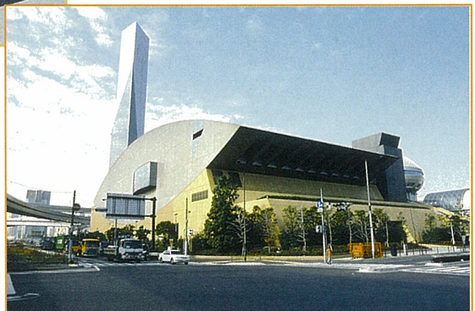
有明清掃工場
