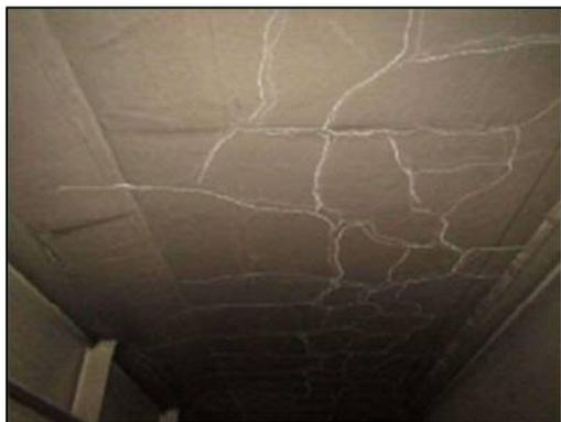
写真 2-3 コンクリートのひび割れ (床版)
