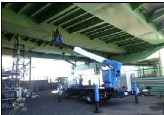
**写真 2-1 桁の損傷調査（陸上）**
