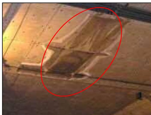
写真 2-20 耐火板の劣化
