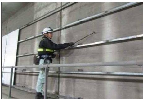
写真 2-9 コンクリート躯体の変状調査
