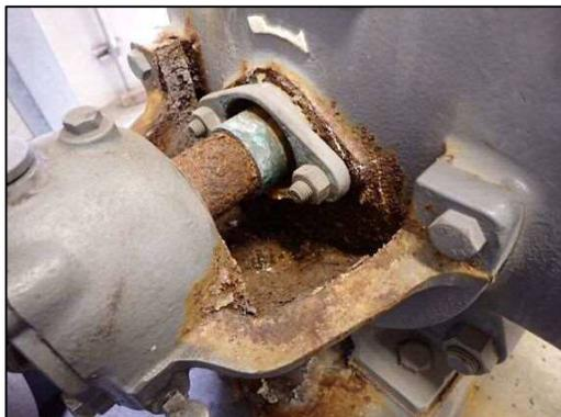
写真 2-21 ポンプ回転軸の劣化
