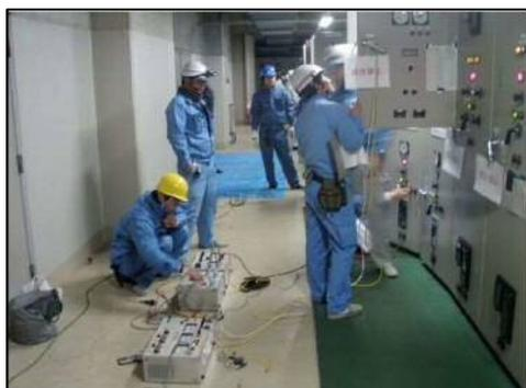
写真 2-13 受変電設備の動作確認状況
