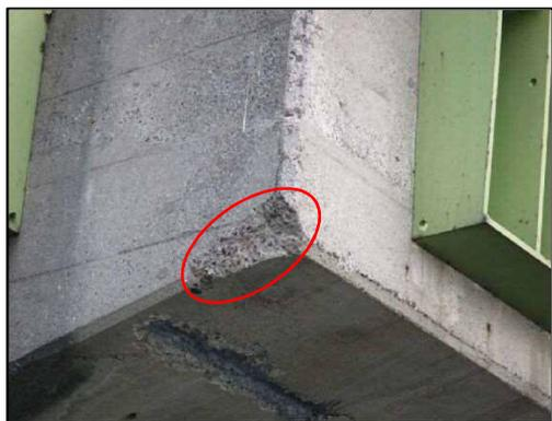
写真 2-5 コンクリートの欠損
