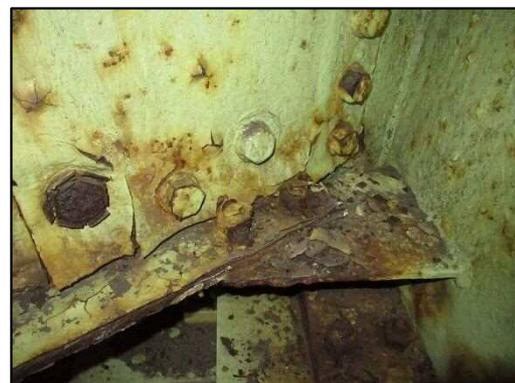
写真 2-8 鋼材の腐食 (桁接合部)
