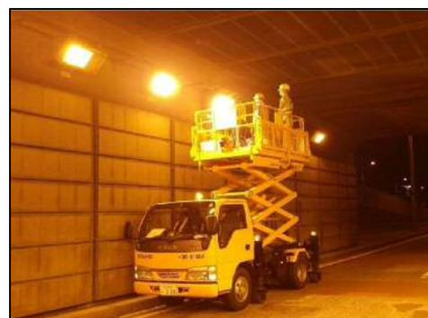
写真 2-16 照明設備の損傷確認状況
