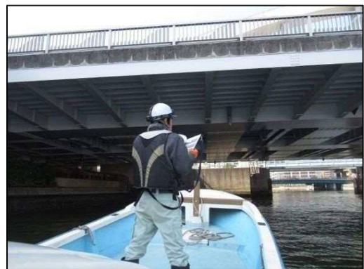
**写真 2-2 床版の損傷調査（海上）**
