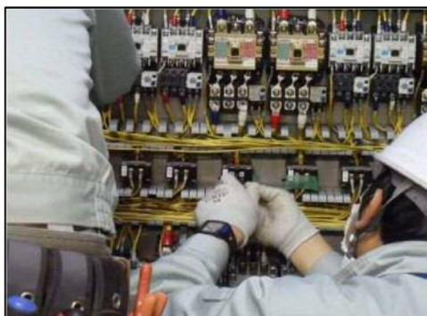
写真 2-15 電気設備の動作確認状況
