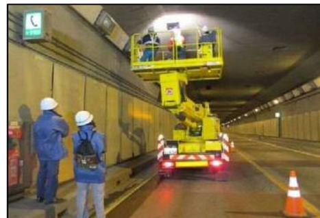
写真 2-10 耐火板の変状調査
