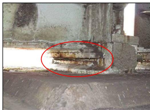
写真 2-6 鋼材の腐食 (支承)
