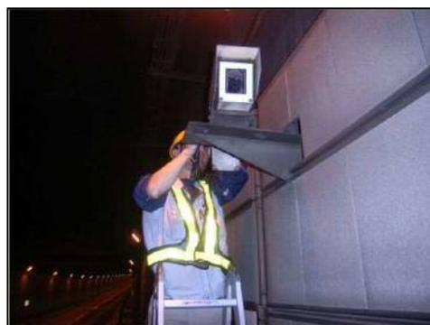
写真 2-14 監視カメラの動作確認状況
