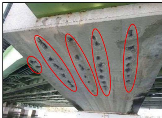
写真 2-4 鉄筋の露出 (橋脚梁下面)
