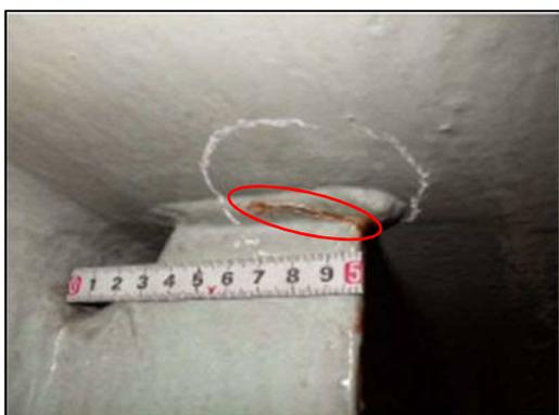
写真 2-7 鋼材の亀裂 (桁溶接部)
