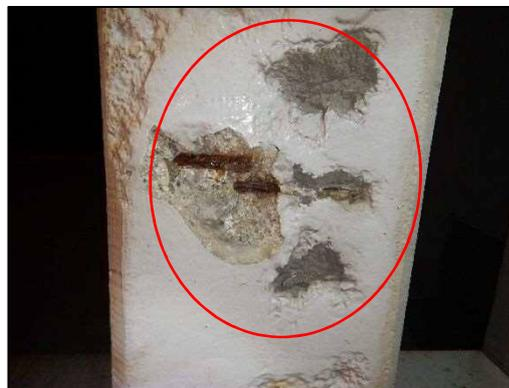
写真 2-18 剥離・鉄筋露出
