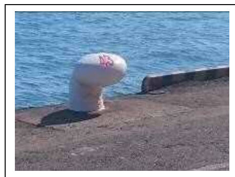
係船柱の維持補修
