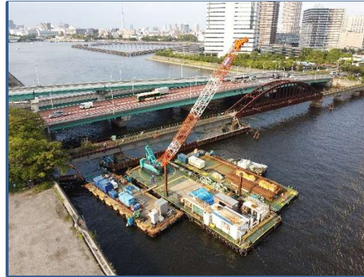
矢板打設工 令和3年8月
