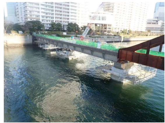
橋脚補強完了 令和5年2月
