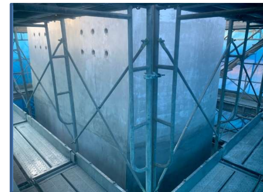
橋脚補強工（乾式吹付完了） 令和4年1月
