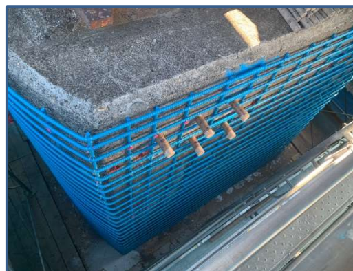
鉄筋組立完了 令和3年12月
