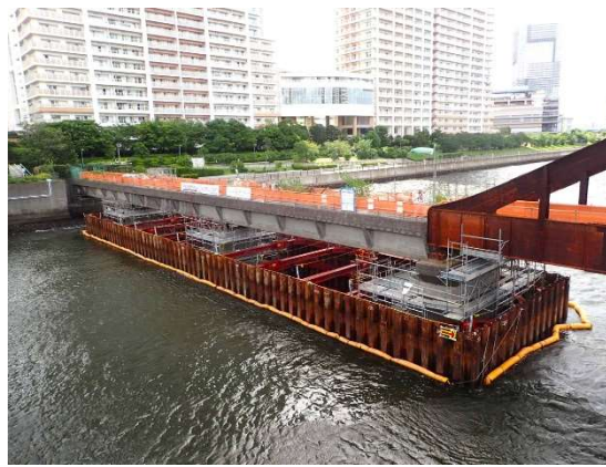
仮締切設置完了 令和4年8月
