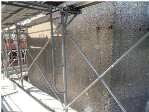
コンクリート表面処理完了 令和3年10月
