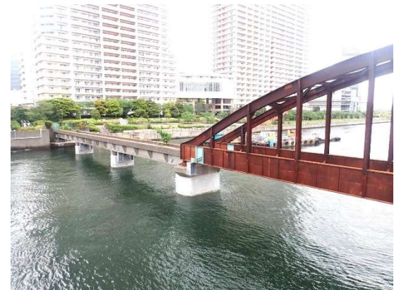
耐震補強工完了 令和5年4月
