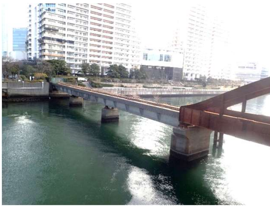
着工前 令和4年2月
