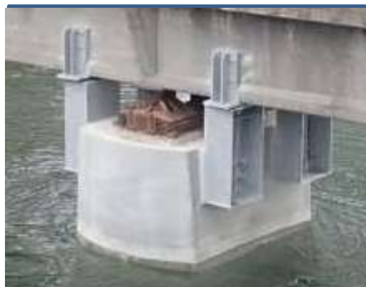
落橋防止システム完了(橋脚) 令和5年4月
