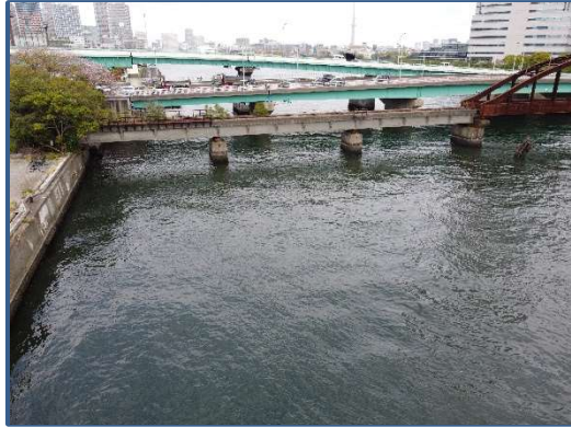
着工前 令和3年4月
