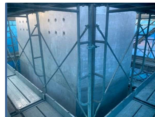
橋脚補強工（乾式吹付完了） 令和4年1月
