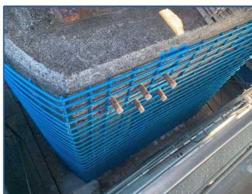
鉄筋組立完了 令和3年12月
