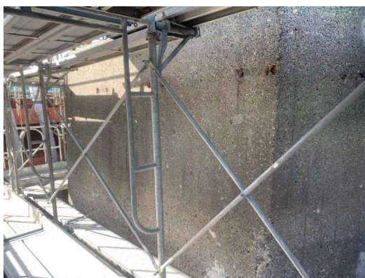
コンクリート表面処理完了 令和3年10月
