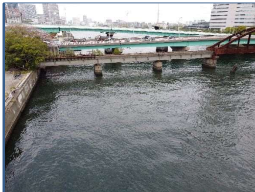
着工前 令和3年4月
