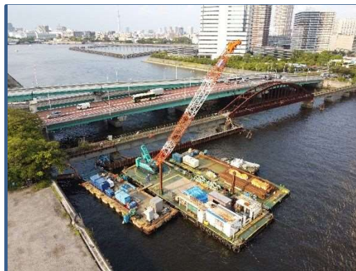
矢板打設工 令和3年8月
