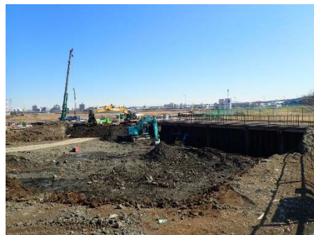
土工 全景写真
