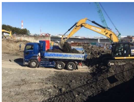
土工 積み込み
