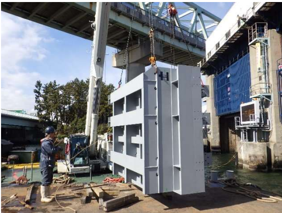
水門仮締切工(部材吊上げ) 令和4年2月
