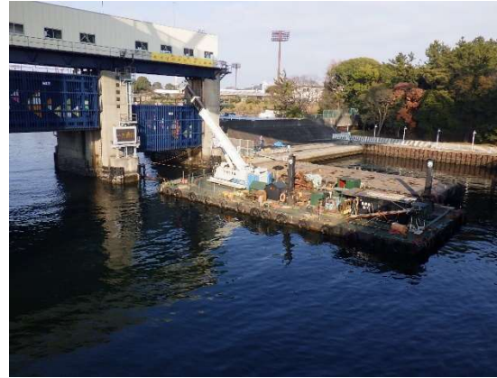
クレーン台船入港 令和4年1月
