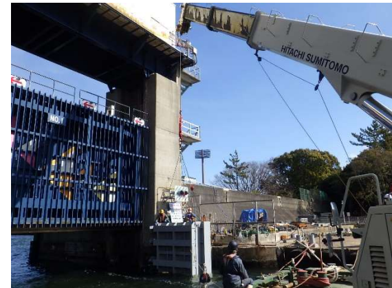
水門仮締切工(部材設置) 令和4年2月
