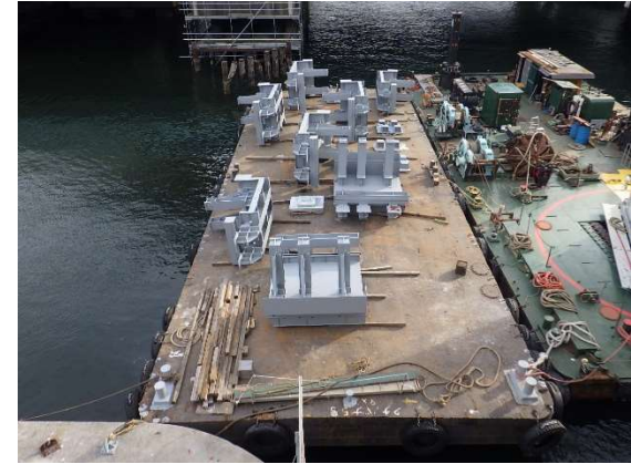
水門仮締切工(部材搬入) 令和4年2月
