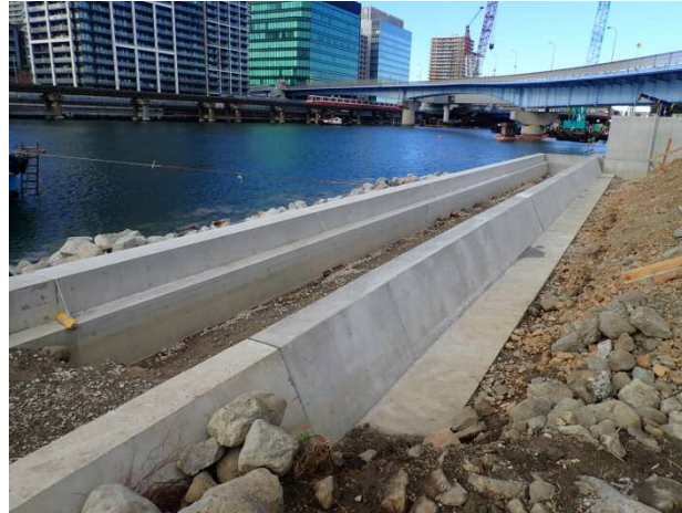
1工区 上部工 平成30年12月
