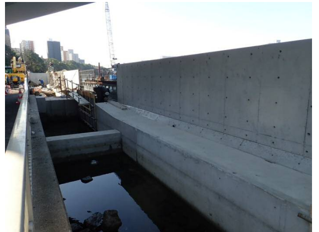
2工区 上部工 平成31年1月
