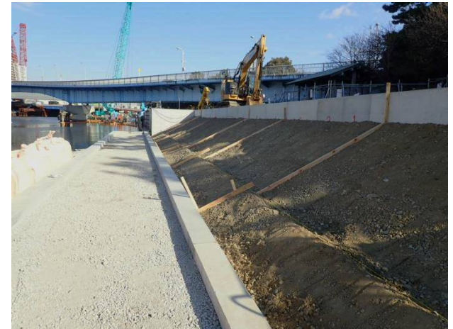
1工区 裏込工 平成31年1月
