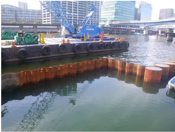
1工区 鋼矢板打設 平成30年7月
