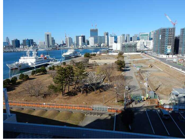
全景 平成31年1月
