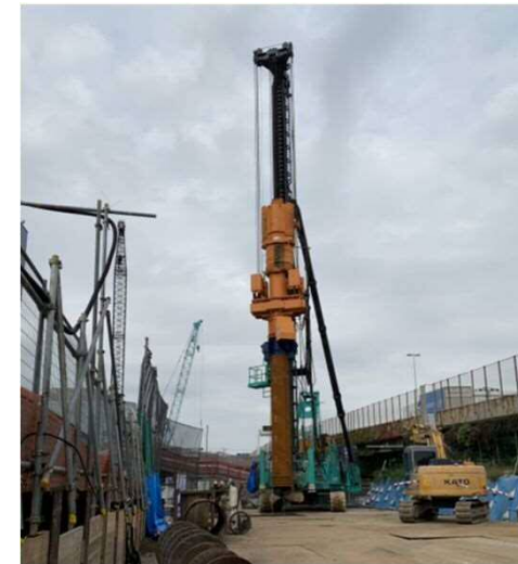
鋼管杭A2橋台打設状況 令和2年10月
