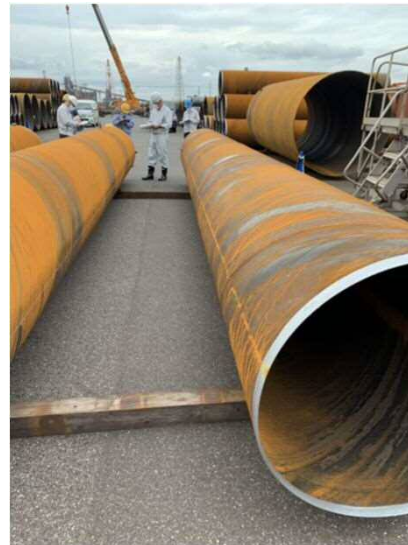
鋼管杭製作状況 令和2年10月
