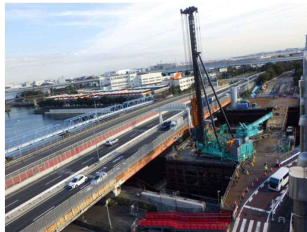
鋼管杭P1橋脚打設状況 令和3年2月
