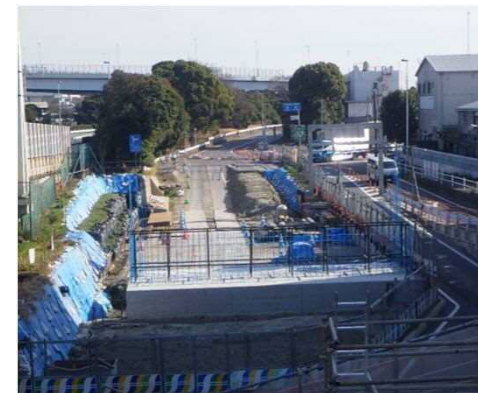
A2橋台建設状況 令和3年2月
