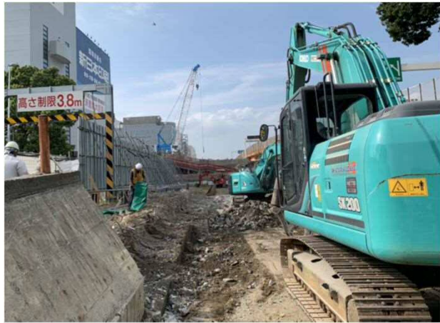
既設擁壁撤去 令和2年8月
