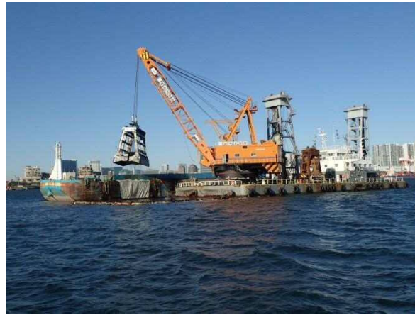
しゅんせつ工
