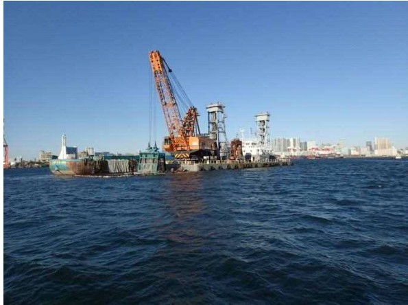
しゅんせつ工
