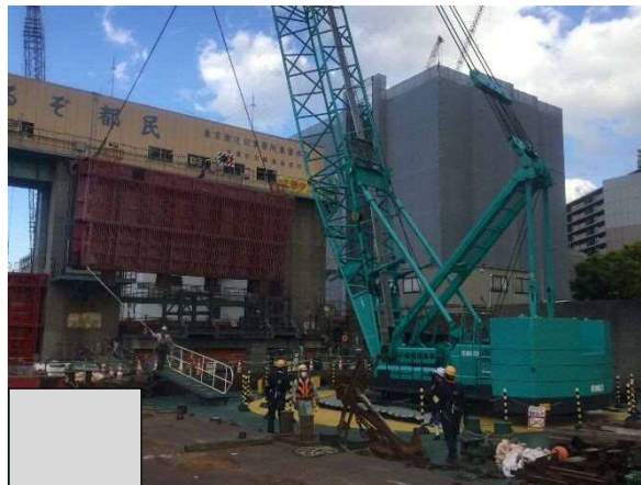
既設上段扉撤去 令和2年11月
