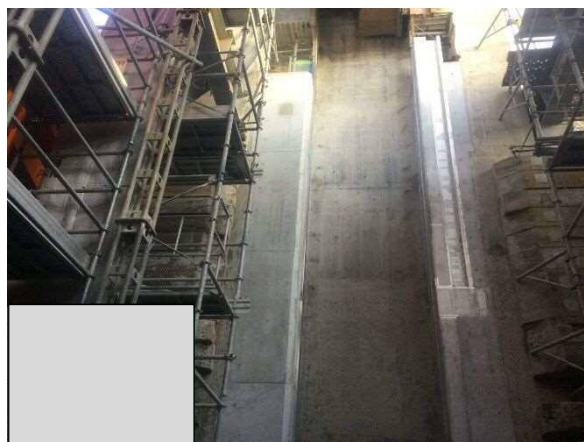
戸当り（重構造部）据付 令和3年2月
