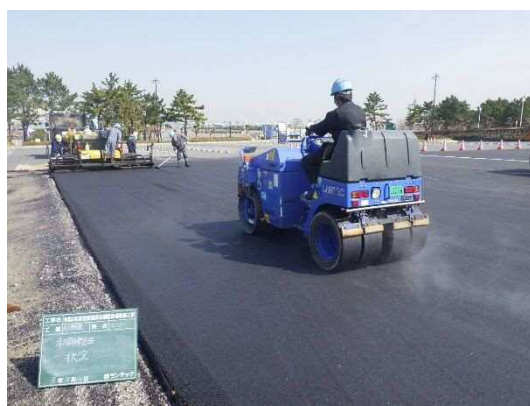
初期転圧 令和3年3月
