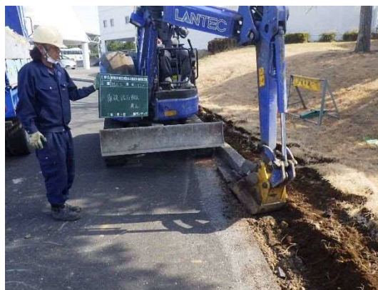
コンクリート縁石撤去 令和3年3月
