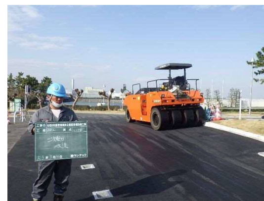
二次転圧 令和3年3月
