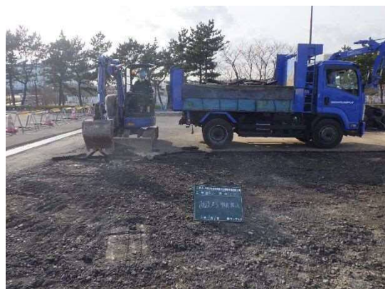
アスファルト舗装版撤去 令和3年3月
