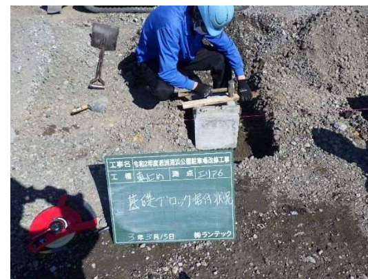
車止め基礎ブロック据付 令和3年3月
