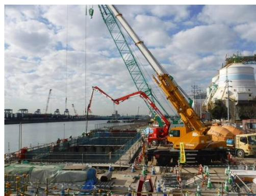
鋼管矢板中詰コンクリート打設
