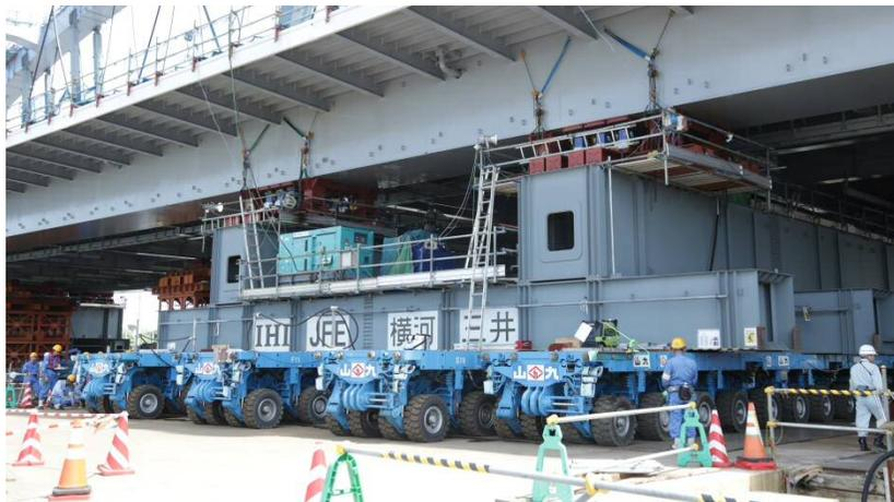
多軸台車への桁搭載状況
