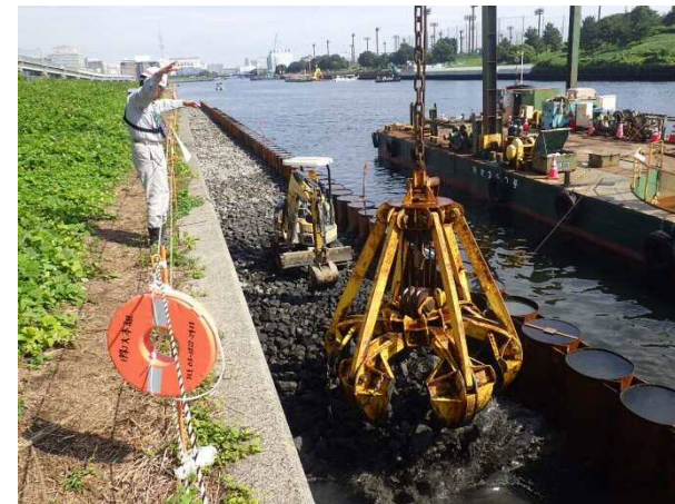
裏込工 平成29年9月
