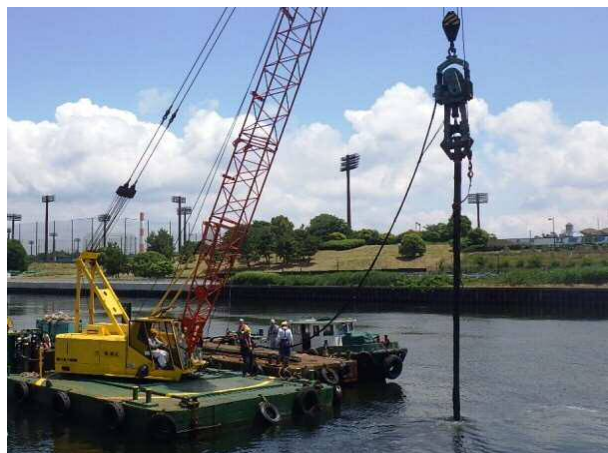
支障物撤去 平成29年6月
