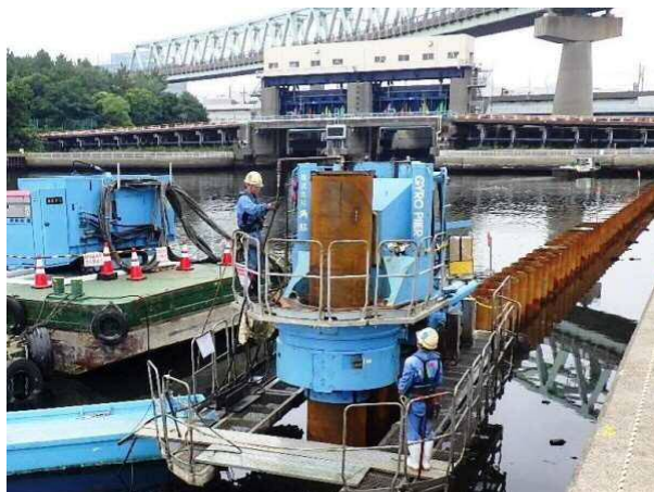
鋼管杭打設 平成29年8月
