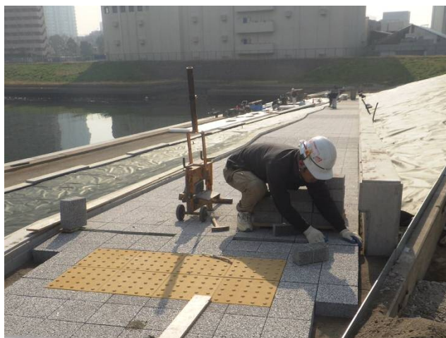
舗装工 平成30年3月
