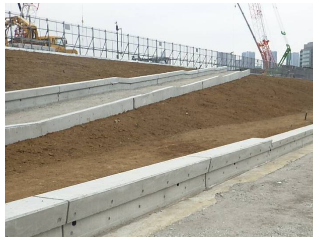
土留工 平成30年2月
