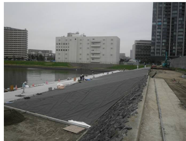
防草シート敷設 平成30年3月
