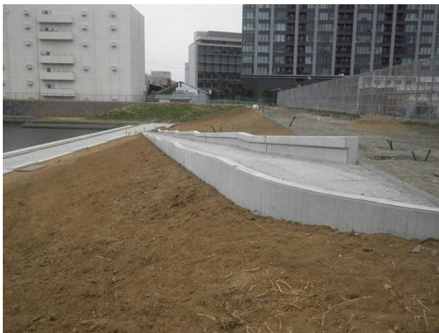
スロープ設置工 平成30年2月
