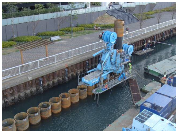
鋼管矢板圧入 平成29年2月
