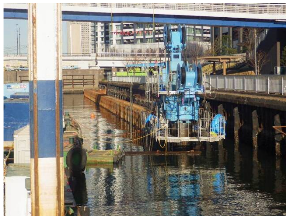
鋼管矢板圧入 平成29年2月
