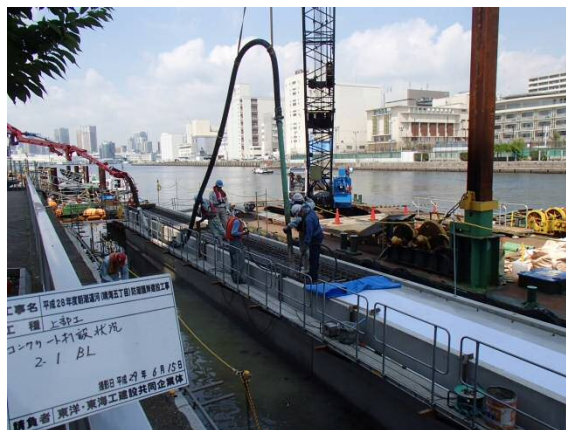
コンクリート打設 平成29年6月
