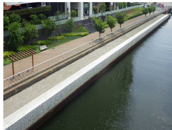
工事完了 平成29年7月
