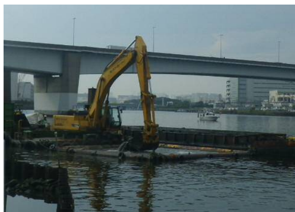
床掘 平成29年7月
