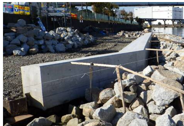
上部工 平成29年11月
