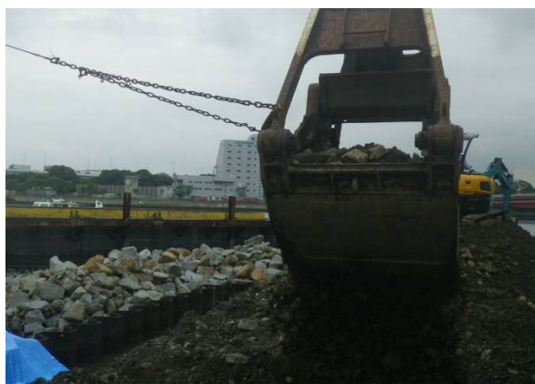
裏込工 平成29年9月
