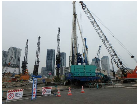
鋼管杭打設 平成29年3月
