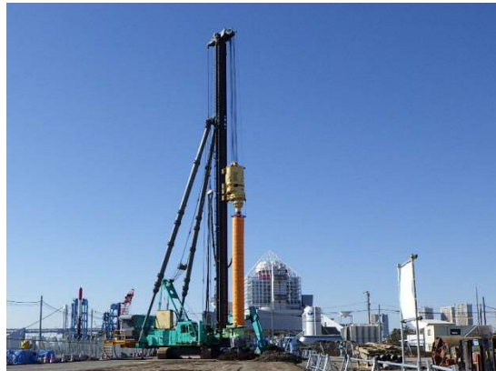
地盤改良(深層混合処理工) 平成29年2月
