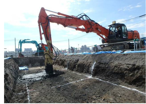
地盤改良(中層混合処理工) 平成29年3月
