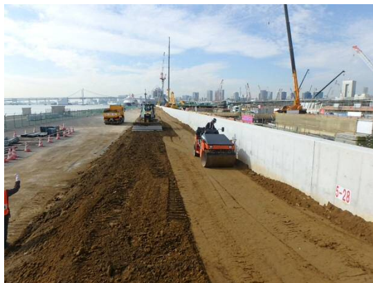
盛土工 平成29年10月
