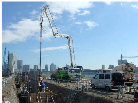
擁壁工(コンクリート打設) 平成29年3月
