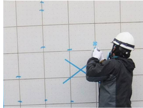
臨港広場外壁（外壁補修） 平成29年12月
