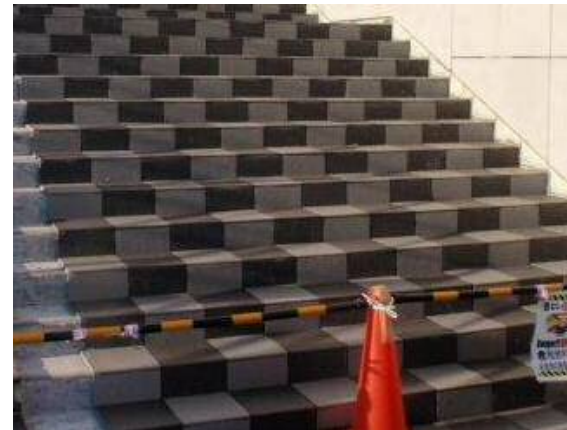
屋外大階段（タイル張り） 平成29年12月
