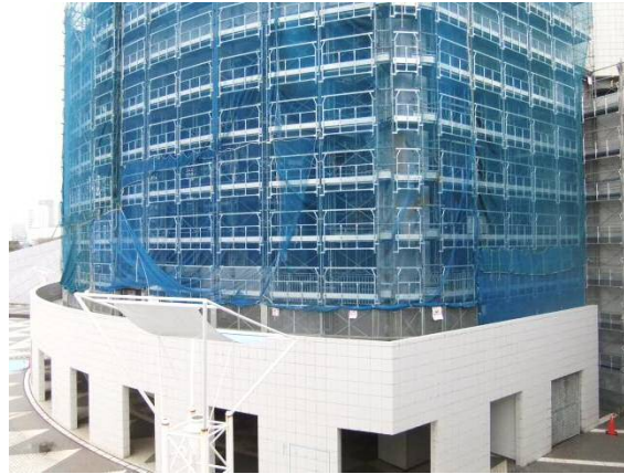
臨港広場外壁（仮設足場設置） 平成29年12月
